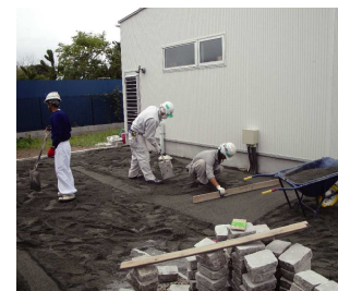
敷砂転圧・高さ調整
