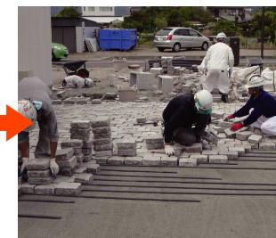
ガイドレール敷設
